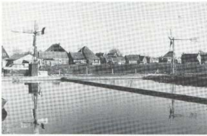
De oxidatievijver in Warmhuizen. Links de windmolens voor aandrijving van de compressor voor beluchting, rechts de molens voor de recirculatiepomp.
